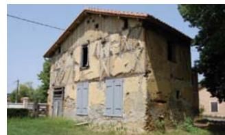
Travaux réalisés et en cours : réfection de la toiture restauration du torchis et des couches de finitions
