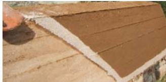
Mur en construction - étape a) mise d'une banchée, étape en cours de remplissage © Chastan Bour
