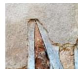
La dégradation de l'enduit de surface dévoile la première couche d'enduit de terre et de torchis de remplissage. Lorsque par un séchage ou un lavement le mortier laisse apparaître les fibres végétales sur le support de terre. Colson et Fontaine.
