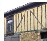
Très sensible aux remontées d'humidité, le torchis est mis en contact avec des matériaux poreux. Colson et Fontaine.
