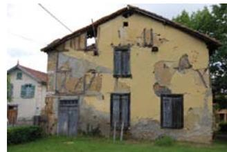
Réalisation du diagnostic : dépose de l'enduit afin de vérifier l'état de la structure pans de bois et de torchis
